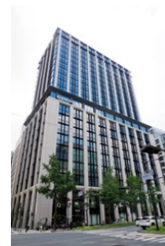
⑰伏見町三丁目地区 (三菱UFJ銀行大阪ビル)
