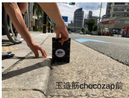
車歩道縁石高さ 3 cm
