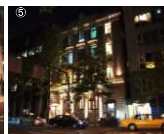
船場地区・地域組織によるライトアップ（近代建築のNW）
