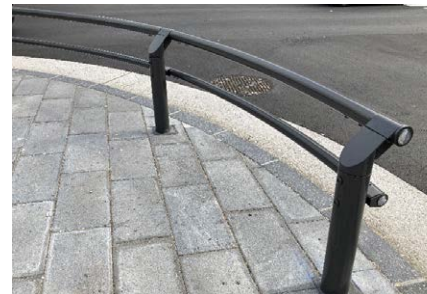
御堂筋・道頓堀橋南詰交差点付近
