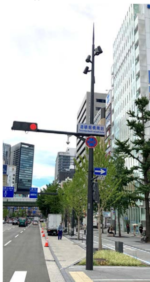
御堂筋・道頓堀橋南詰交差点付近
