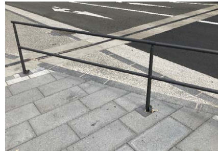
御堂筋・道頓堀橋南詰交差点付近
