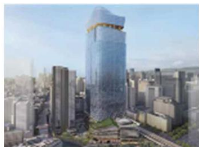
常盤橋プロジェクト（TOKYO TORCH）
