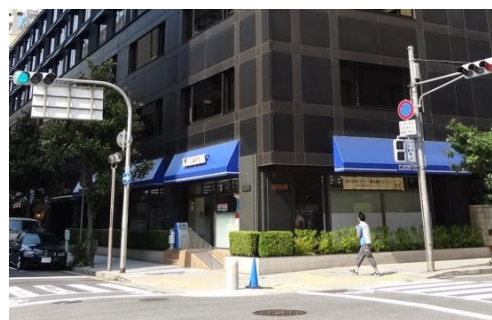
まちなみに配慮し、日よけ TENT 型のサインを採用しているコンビニエンスストアの例。TENT の色は、企業カラーの明度・彩度も落としています。
