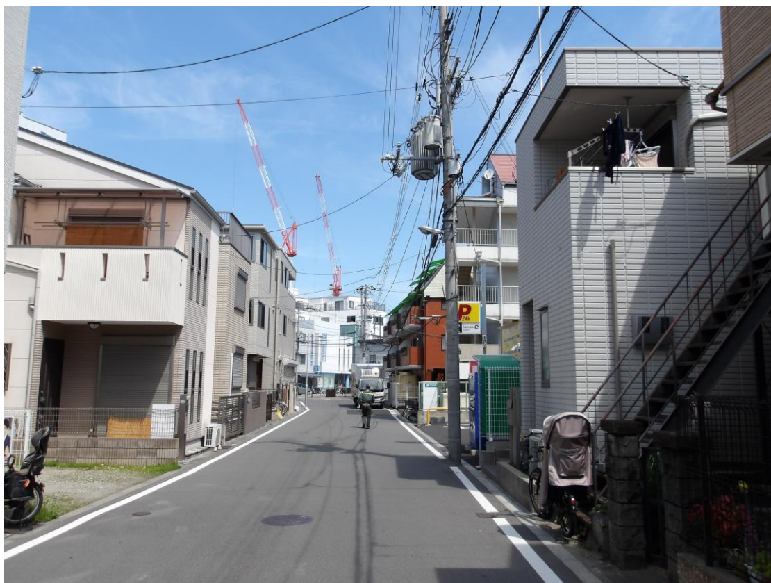
⑧' 現在の整備状況（令和 6 年 4 月） 区画道路 7 号線
