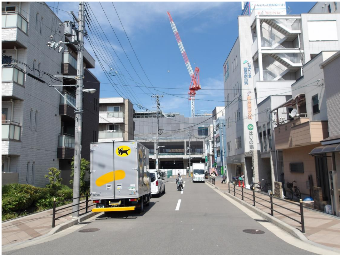
⑨' 現在の整備状況（令和6年4月） 区画道路9号線
