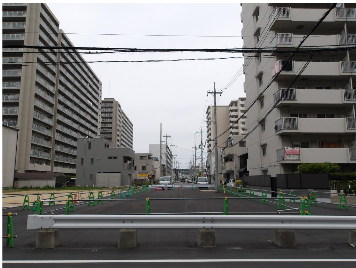
②' 現在の整備状況（令和6年4月）
