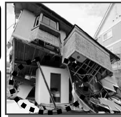
【シェルター型耐震改修の例】
