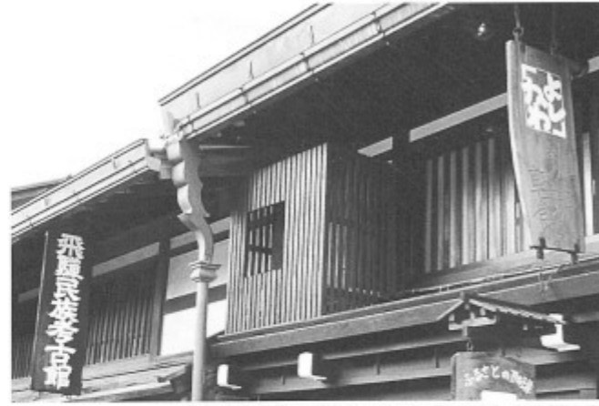
空調の室外機などを格子などで目かくしするだけで、まちへの印象が全く違うものになります。(高山市)
