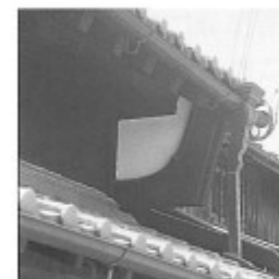
うだつ（袖うだつ） 町家の2階部分の正面両側につけられた袖壁で、防火や目隠しの役割があります。
