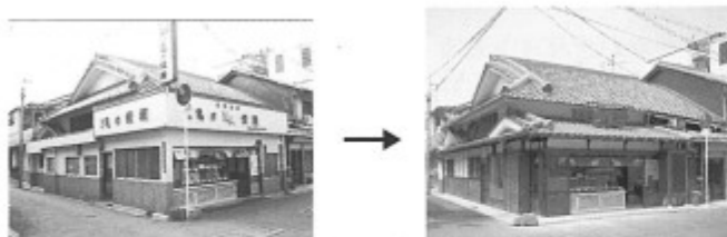
パラペットを外し、伝統的な町家の外観輪郭を復元した例
