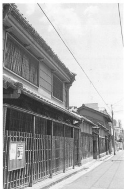
道路に沿って伝統的建物の輪郭が連ち並び、美しく連続感のあるまちなみ景観を形成しています。
