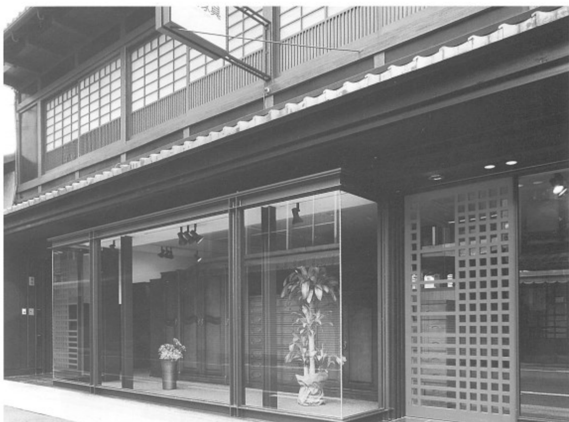
ショーウィンドウに鉄骨を用いた例。 新しい素材を使う場合は、色などに配慮してまちなみになじませます。(京都市)
