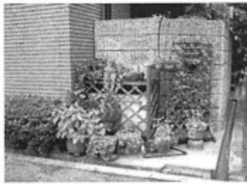
住吉では室外機を植栽により目隠しされている事例もあります。
