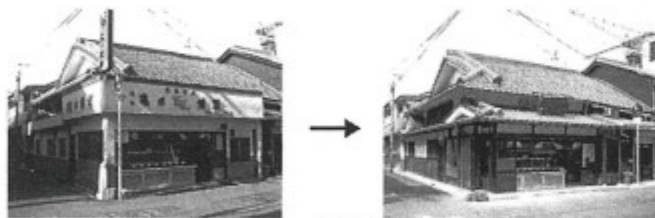
バラベット（9頁参照）を外し、伝統的な町家の外観輪郭を復元した例（平野郷地区）
