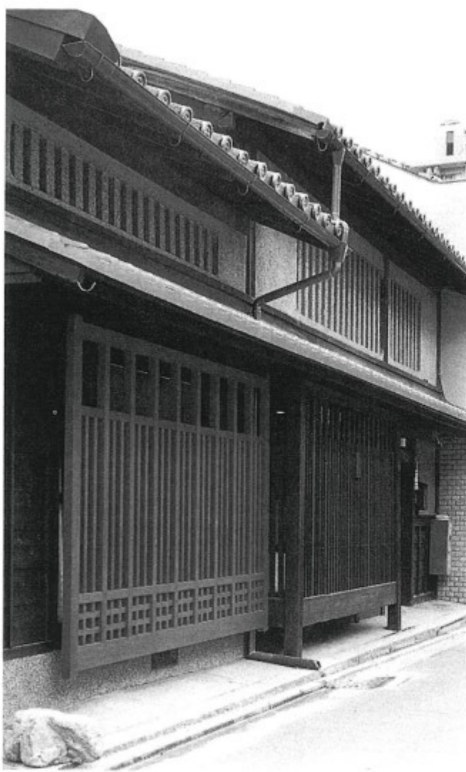
京都市の事例 新しくデザインされた格子が用いられています。
