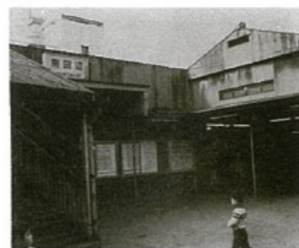
国鉄(現JR)阪和線南田辺駅(昭和4年開通)
