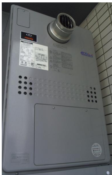
給湯設備：潜熱回収型給湯器（エコジョーズ）
