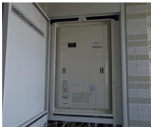
給湯設備：潜熱回収型給湯器（エコジョーズ）
