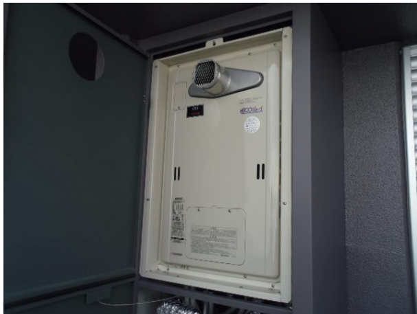
給湯設備：潜熱回収型給湯器（エコジョーズ）
