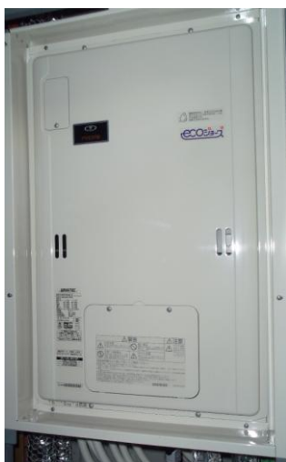
給湯設備：潜熱回収型給湯器（エコシース）
