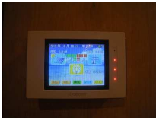
居住者の環境意識を高める設備 太陽光発電量表示システム
