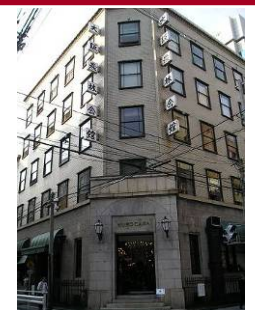
大阪農林会館ビル
