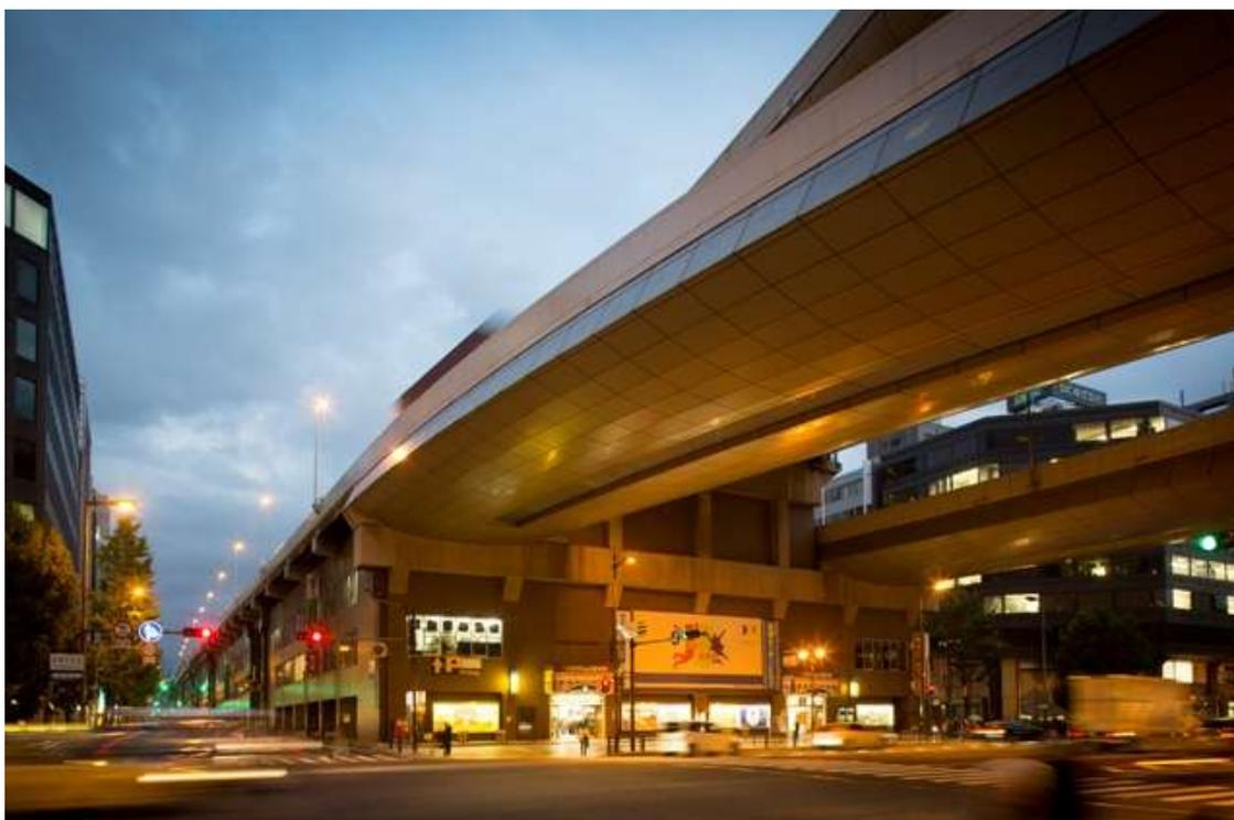
大きすぎてかえって意識しない建築もある。船場センタービルがそれだ。全長は約930mで、上部には一般道と阪神高速道路の計12車線が走る。道路の傾斜に合わせて階高は1階から4階まで変化し、計10棟が内部でつながる。特に御堂筋や堺筋と交差するあたりの外観は、土木と建築が融合して圧倒的だ。豊臣秀吉の築城以来、商業の中心地として栄えた船場地区に高速道路を通すにあたって、ビルを建築し、その上に道路を構築し、ビルと道路が一体構造というアイデアで商業者の移転先を確保。ビル床の売却代金で事業費を削減し、1970年の日本万国博覧会に間に合わせた。かつての構想力や実行力の大きさ、大阪の先進性の証である。(倉方俊輔)
