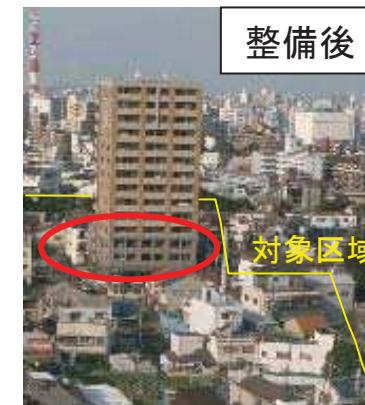
淡路駅周辺地区(平成18年撮影)
