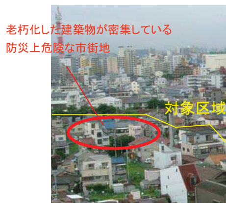
淡路駅周辺地区(平成15年撮影)
