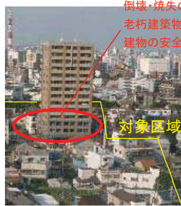
淡路駅周辺地区(平成18年撮影)
