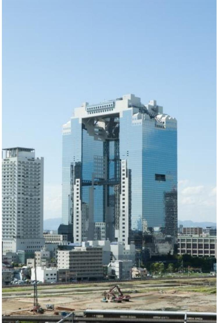
約50m離れて建つ2棟を最頂部の39・40階で接続させた、世界で初めての連結超高層ビル。高さ173mは完成当時、西日本一だった。外装の大部分を占めるガラスカーテンウォールに空が映り込み、「空中庭園」と命名された連結部が浮遊して見える。そこに空いた環に「空中エスカレーター」で上がる体験も前代未聞。細部には多様なデザインを混在させて、未来の集落を思わせる景観を形作っている。全体から部分まで設計者の建築観が色濃く、わが国でも数少ない、建築家の作品と呼ぶにふさわしい超高層ビルとなっている。物理的な高さで抜かれても、思想性の高さにおいては、いまだ世界でトップクラスだ。（倉方俊輔）
