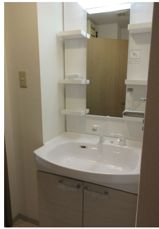
洗面設備の新設・改良
