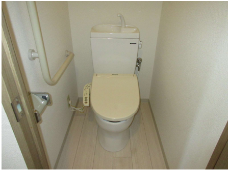
節水型トイレへの取替え
