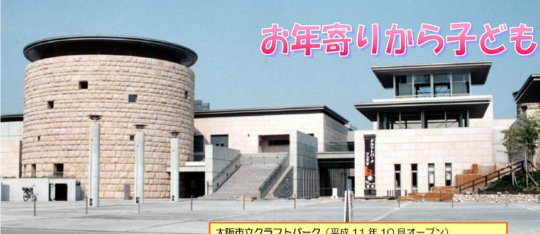
大阪市立クラフトパーク（平成11年10月オープン） ものづくり（クラフト）へのニーズの高まりに応え、新しい文化創造の場所として提供されています。
