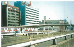
西中島南方付近
