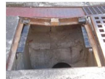
枠の損傷（蓋の浮きの原因）
