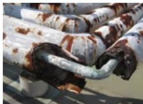
配管断熱材の損傷
