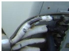
配管断熱材の剥れ
