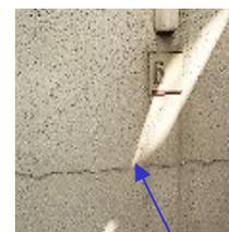
仕上げ材のひび割れ
