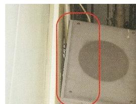
拡声装置の取付不良❖<sup>3</sup>
