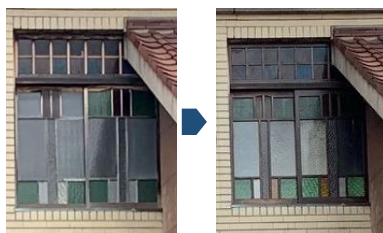
窓枠を既存のデザインに合わせて木製で復元した例
