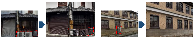
室外機を塗装した事例
