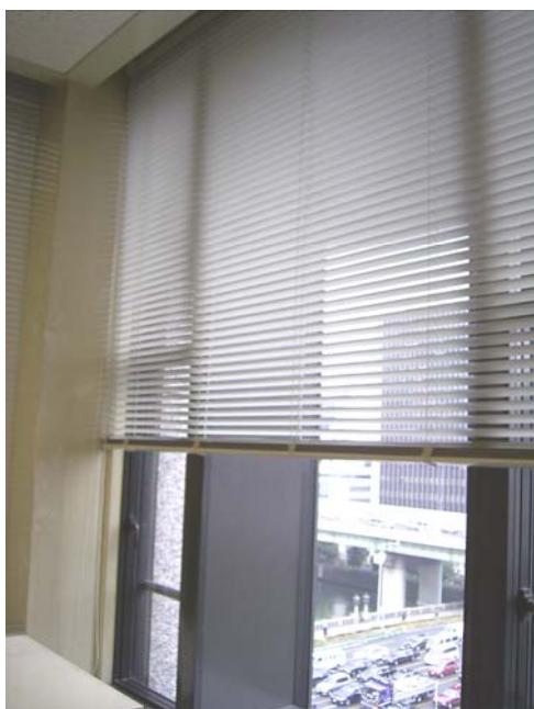
ブラインドの開閉による日射制御
