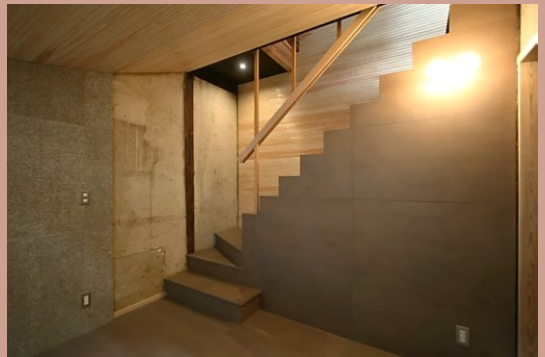
既存の階段の撤去を伴うもので、勾配を緩和する工事 before after
