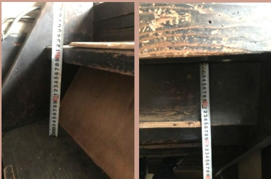
既存の階段の撤去を伴うもので、勾配を緩和する工事 before after
