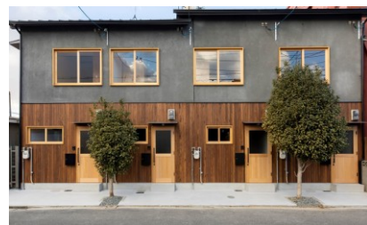
改修後の外観▼
