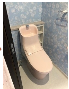
トイレの改修工事
