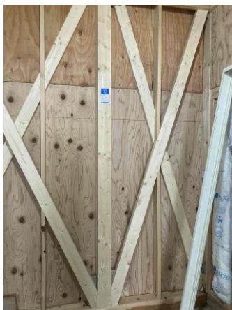
▲ 耐震補強の例 (筋交いの設置・金物の設置・基礎の新設)
