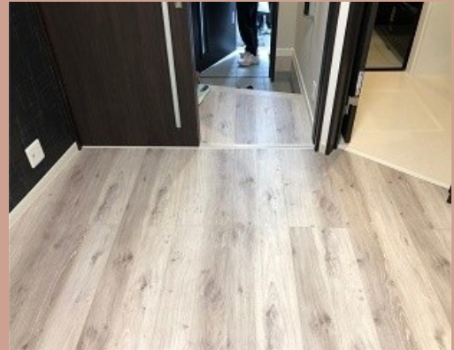
玄関とリビングを結ぶ経路の段差を解消する工事
