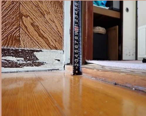
玄関とリビングを結ぶ経路の段差を解消する工事
