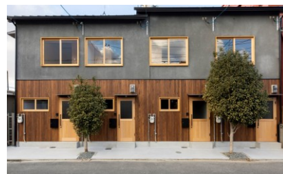
改修後の外観▼
