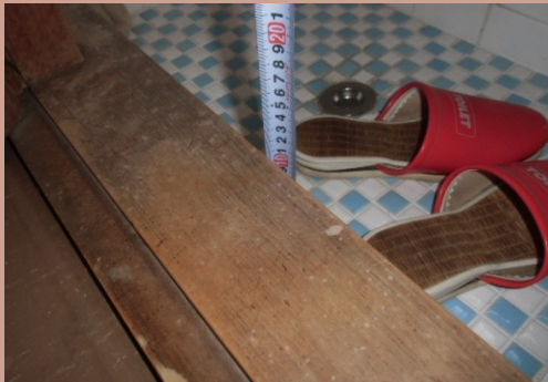
トイレの出入り口の段差を解消する工事
