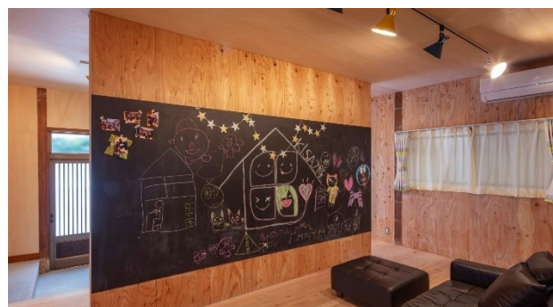
▲耐震の補強壁に大きな黒板を設置したお絵描きスペース
