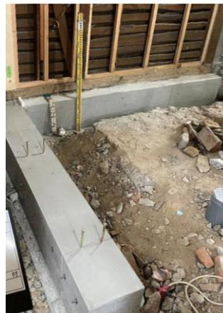
▲ 耐震補強の例（筋交いの設置・金物の設置・基礎の新設）
