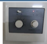
【電気室(温度スイッチ・排気ファン)】
