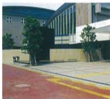
東淀川屋内プール
