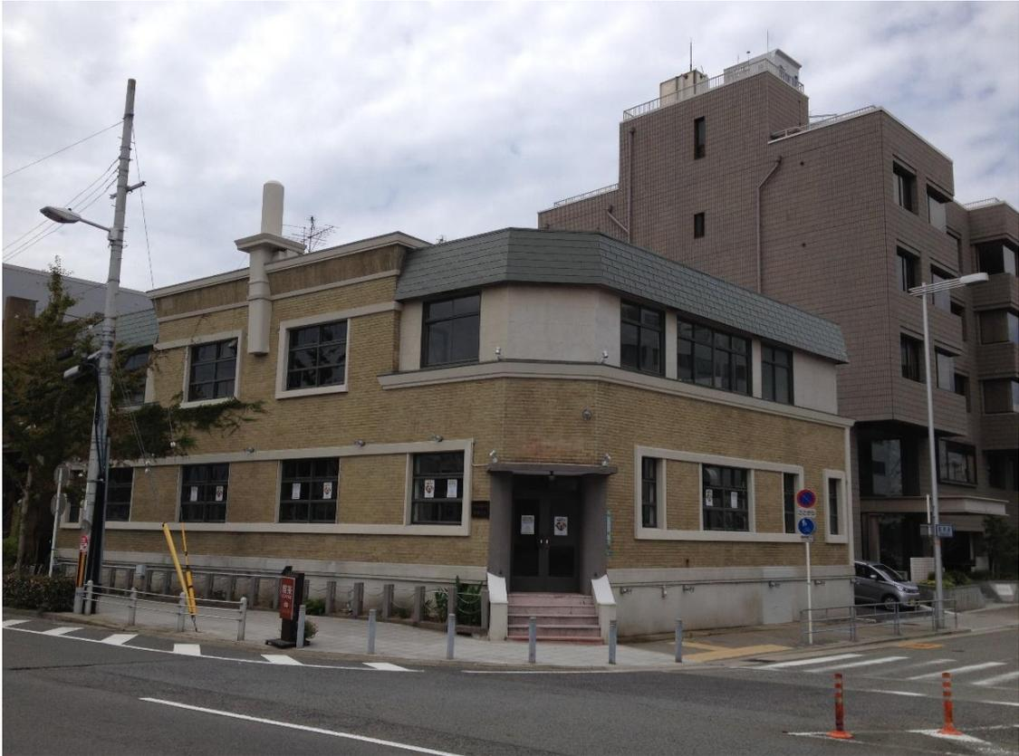
1903（明治36）年に整備された築港大棧橋（現・中央突堤）のたもとに、天満屋ビルと肩を並べて建つ中谷運輸築港ビルは、1933（昭和8）年に大阪商船（現・商船三井）が、船舶の切符売場兼船員の待合所として建てた近代建築。現在は2階建に見えるが、実は竣工当時は地上3階建だった。大阪の海に近いエリアは昔から地盤が低く、台風などの水害に繰り返し悩まされてきたことから、戦後の復興事業によってこのあたりの道路全体が2mほど嵩上げされた。その結果、建物の1階がほぼ地中に埋まってしまったのだ。南側の立面がシンメトリーなのに、入口が右の角に設けられているのは、嵩上げされた際に新しく設けられたから。また当初は全体が凸型の形態で、両肩の部分は後に増築されている。解体の危機をくぐり抜け、1階に飲食店などが入居して活用されている。（高岡伸一）
