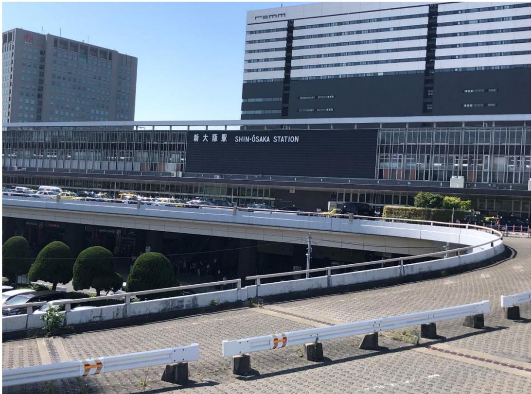
世界初の高速鉄道として1964年に開業した東海道新幹線は、駅舎の設計思想も新しくなった。建物の中に線路が入り込むのではなく、構造体である高架橋の内部にプラットフォームや駅舎に必要な諸施設が収まる形で設計されたのである。したがって、駅舎は細長くスマートになり、外から見ただけでも、新技術を投入した車両こそが主役であることを教える。そんな当時新鮮なイメージは今も、東海道新幹線の終着駅として新たに建設された新大阪駅の特徴となっている。とりわけ駐車場などがあって視界が開けた南面に、完成時の外観が良く残されている。一直線に続くガラス面に80cmと40cmのアルミサッシが割り付けられ、巨大で正確な機構を連想させる。プラットフォームの柱間も統一、在来線や駐車場との乗り換えも最短距離にするなどの合理的な設計が成功して通り過ぎがちなのだが、たまには立ち止まってほしい。(倉方俊輔)
