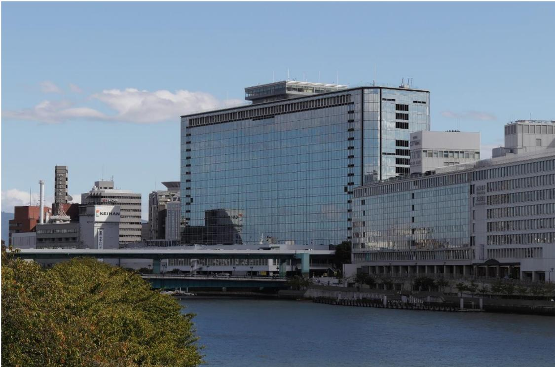
戦後の大阪の都心部は古くからの問屋がひしめき合い、狭い道路を前にした商いは、慢性的な交通渋滞を引き起こしていた。その問題を解決すべく計画されたのが、問屋街を立体的に積み上げた OMM ビル。京阪が終点を天満橋駅から淀屋橋駅まで延伸させたことで生まれた敷地に、当時としては西日本最高の高さを誇る地上 22 階建の高層ビルが、線路の上空に建設された。ビルの最上階には、自慢の眺望を活かして回転展望レストランが設けられ、1973 年からは 20 階の屋上にビアガーデンがオープンして人気を博した。当初の外装はコンクリートのパネルだったが、1989（平成元）年の改修で、川面と空を大きく映し出す、ガラスカーテンウォールへと替えられている。最近の超高層ビルに高さでは叶わないが、東に大阪城公園、西に中之島を見下ろす絶景は今も健在。（高岡伸一）
