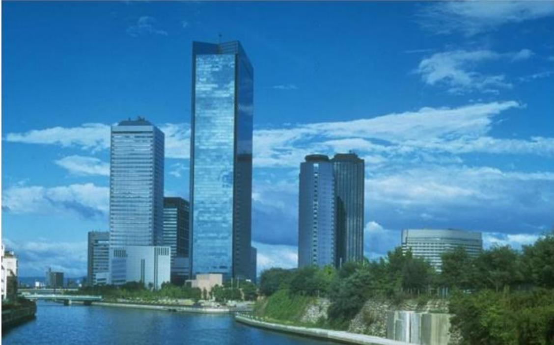
1970年代から計画が進められ、1986年に街開きを行った大阪市内初の民間による大規模開発「大阪ビジネスパーク」のシンボルとして1990年に完成した。ハーフミラーガラスで全面が覆われ、中之島側から眺めた時に川が二手に分かれる突端にあって、抽象彫刻のように視線を受け止めている。「ビジネス」の実直さを最上のレベルで実現させたような、流行に左右されない形が今なお新鮮だ。敷地面積の85%を公開空地とした「パーク」となっていることも同様である。技術的にも新しく、日本で初めて超高層ビルで制震構造が採用された。スレンダーな形態を風の影響から軽減するためだが、アイデアが光っているのは、氷蓄熱層を用いた振り子式制振装置であること。風揺れの原因となる屋上の設備装置の一部を、制振のための振り子として活用している。(倉方俊輔)
