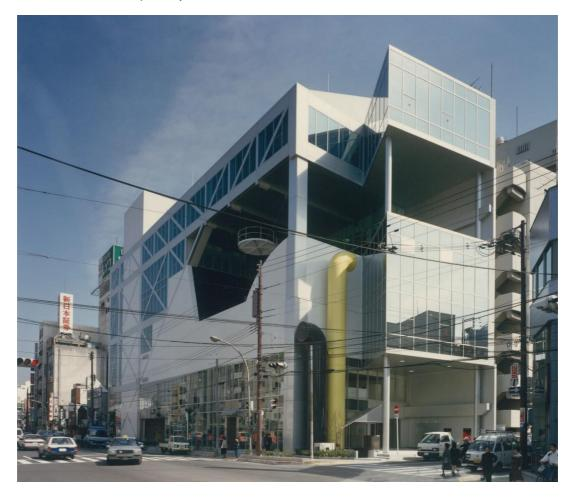
前衛的な住宅作品と言説で 1950 年代から注目され、さまざまな有名建築家に影響を与えてきた篠原一男が設計した大阪で唯一の建築。敷地の北西隅に地下鉄が走っているため、その上には構造の柱を据えられない。したがって、橋状の架構を東側から渡し、その斜め線が北側の国道沿いの見た目を複雑にしている。ガラスとアルミパネルがつくる機械のような外観は南側にも共通するが、こちらの面は街路のカーブをそのまま受け入れて湾曲している。  $1 \sim 2$  階の内部空間には異なる3種類の架構が組み合わされ、即物的な複雑さは $4 \sim 6$  階の外部吹き抜けにも感じられる。立地している京橋はさまざまな交通が交錯し、多彩な用途の建物がひしめく場所である。そんな都市の特性を、建築における複数の原理の衝突へと変換している。(詹 ) 後期
