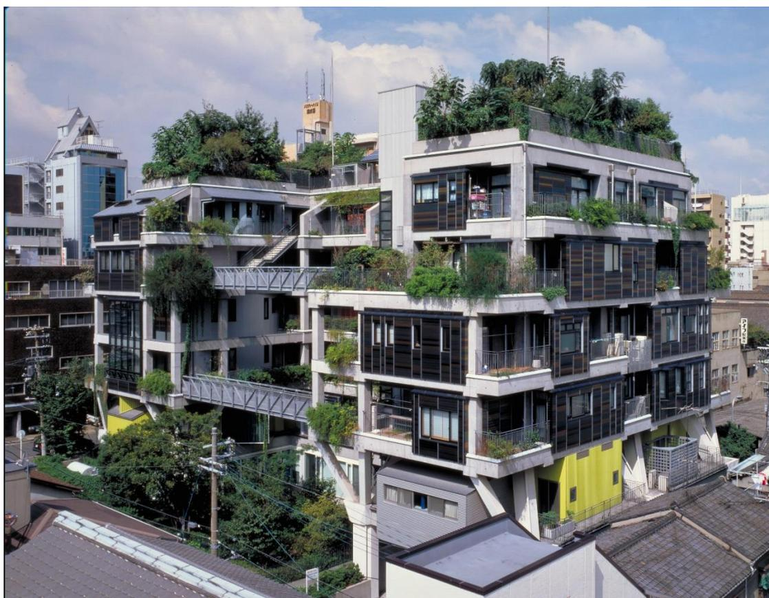
この実験住宅にはスケルトン・インフィル方式が全面的に採用されている。「スケルトン」は建築の専門用語で言うと、構造躯体とのこと。柱や梁など建物を支えている要素を指す。「インフィル」はそれ以外の部分。間仕切り壁や内装、ガス管や水道管といった設備などがこれに入る。この2つをきっぱりと分けてつくろうというのが同方式だ。これによって、短期間の取り壊しを避けながら、住まいとしての性能を高めることが可能になる。外部有識者や住民からの提案を柔軟に試みて、現在に至っている。その間に敷地内の木々は育ち、屋上の緑に渡り鳥が観察され、周辺住民との関係も形成されてきた。スケルトン・インフィル方式という先進的な技術に血が通い、これからの都市の生活への指針が得られ続けている。(倉方俊輔)
