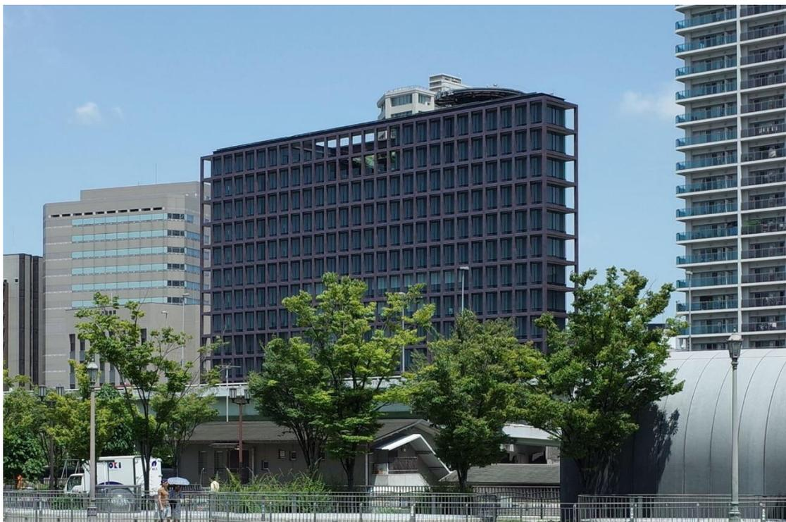
建設を進める上でのコンセプトの第一に「市民に開かれた弁護士会」ということがあった。それが前面道路からも気持ちよく眺められる開放的なエントランスロビーを生んだ。さらに特徴的なのが、ガラスの向こうに見える煉瓦の壁。特注した数種類の形状と無限の色ムラを組み合わせ、織物を思わせる風合いを醸し出している。遠くから見た建物は、細い格子の中に透明なガラスの箱が収まっているかのようだ。構造体を外側に集約させて、将来的な間取りの変更にも対応可能になっている。渋い色味は大きな陶板で柱と梁を覆っているから。開かれた現代的な透明感をガラスで、どっしりと構えて中之島の歴史的な建築にも接続する素材感を焼き物で、共に飾らない「素」の素材で勝負することによって、公共性ある職能団体にふさわしく、都市に美観を提供している。
