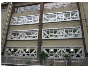
ブレース設置（窓面）
