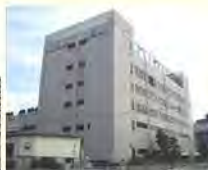
中部環境事業センター
