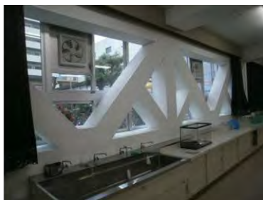
ブレース設置（窓面）
