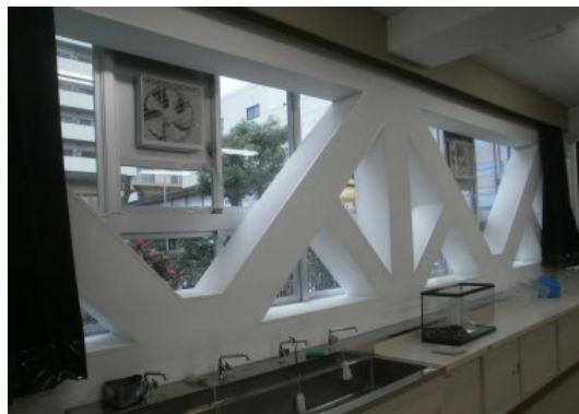
ブレース設置（窓面）
