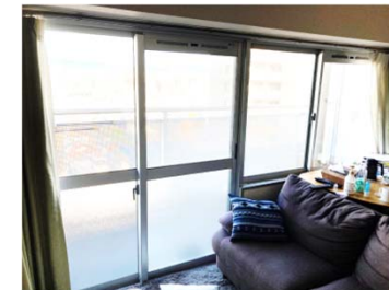
※ 断熱改修を実施する窓の様子
