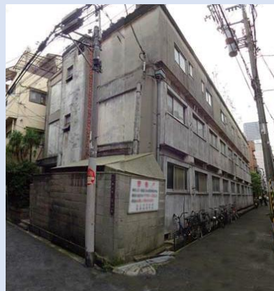
建替前（老朽木造住宅）
