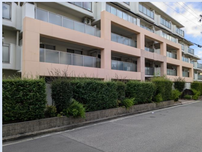
アウトフレームの設置 メゾンドール帝塚山（平成27年度補助事業）
