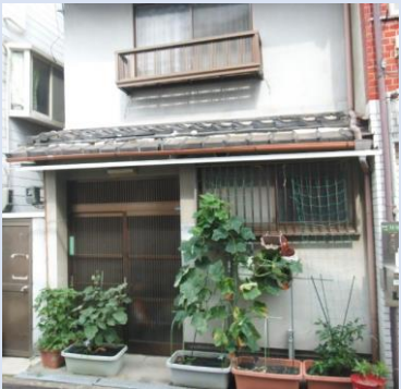
除却前（老朽木造住宅）
