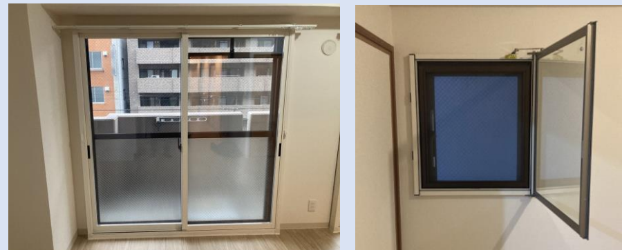
〈活用事例〉共同住宅の事例（内窓設置）
