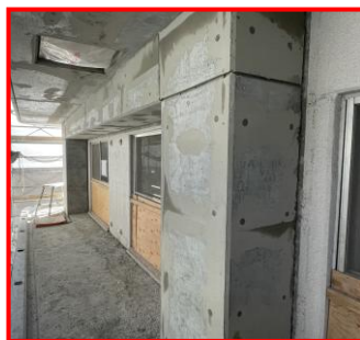
▲ コンクリートの施工
