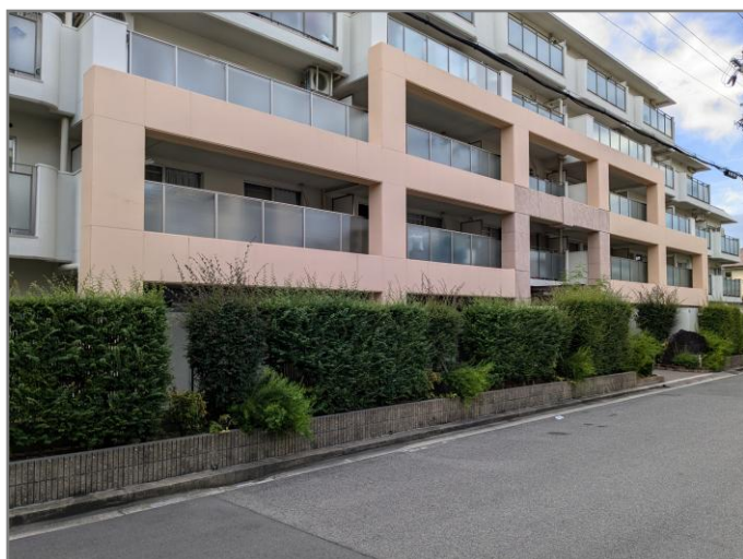
▲ 設置されたアウトフレーム
