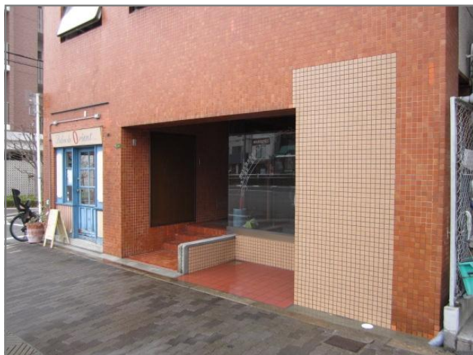
▲ 袖壁が増設された東側の外観
