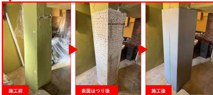
▲ 柱の補強工事
