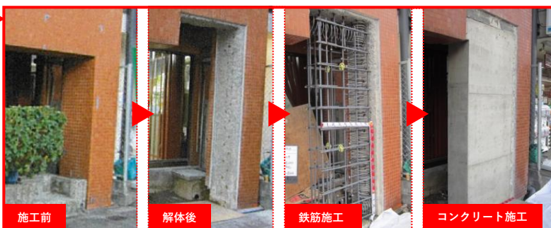
▲ 袖壁の増設工事
