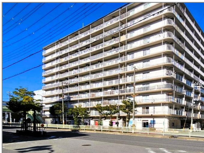
▲ 耐震改修が目立たない仕上がりの外観
