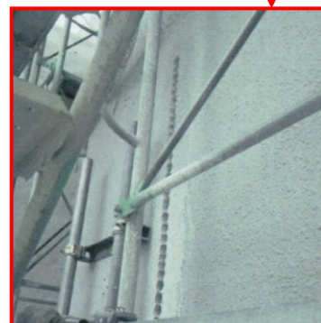
▲ 耐震スリット工事
